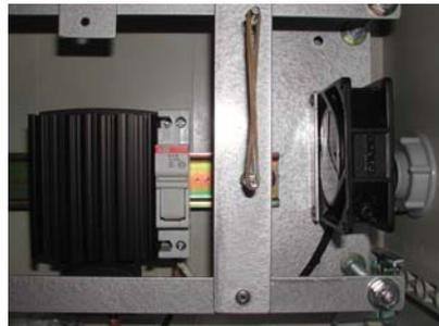
Ventilateur : 80mm x 80mm 230VAC/60Hz 0,09A Résistance thermostatée 8Watts
